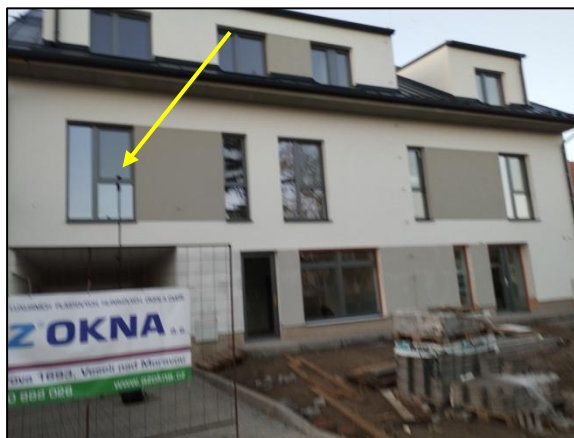
Obrázek č. 2 – pohled na měřicí místo B
